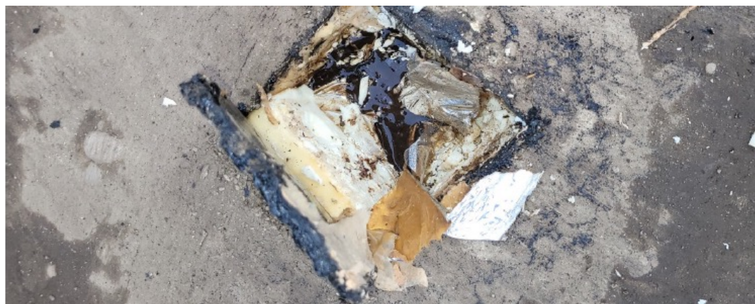
Présence d'eau sous le complexe d'étanchéité.
